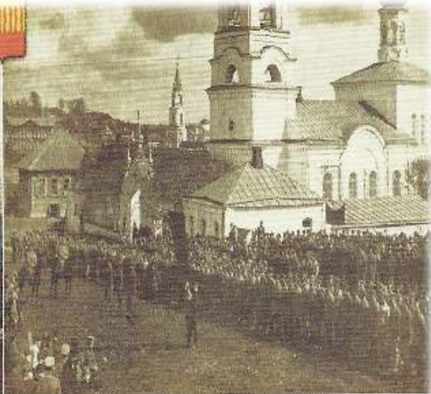
Печерская церковь. Смотр Красной Армии.
